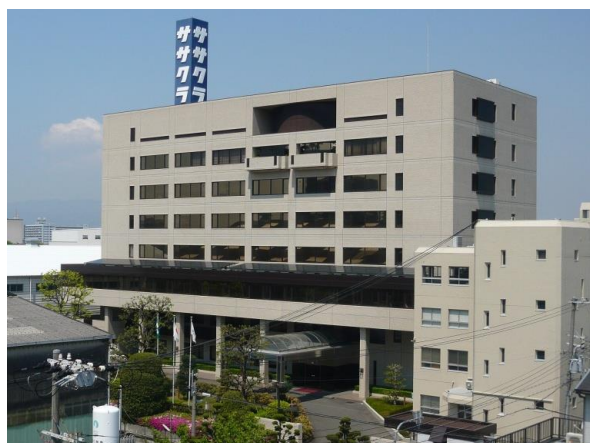
ササクラ 本社 Sasakura Head Office
